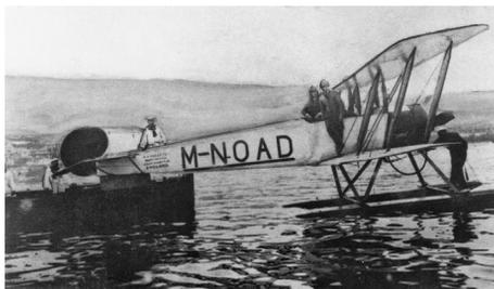
Foto histórica tomada en el puerto de Barcelona, sede de la Escuela de la Aeronáutica Naval con el primer AVRO 504 provisto de flotadores con que contó la Armada para la formación de sus pilotos (1921).
